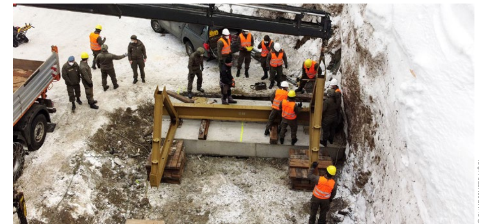
Katastropheneinsätze sind für das Image des Bundesheeres besonders wichtig (hier im Bild errichten Pioniere in Osttirol eine Brücke).
